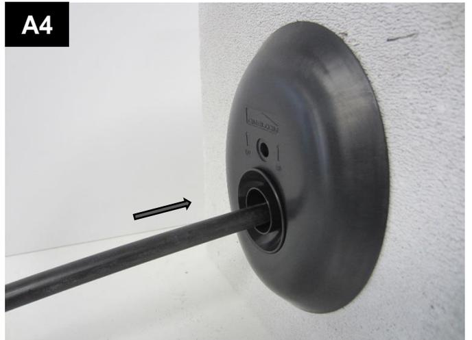
Führen Sie das Kabel/SNR durch die Wand über das System bis zum Anschlusspunkt.
