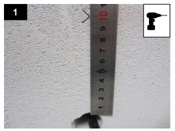
Bohre das Befestigungsloch, Ø6mm, 10 cm vom Rand des Durchgangslochs entfernt in der Biegerichtung des Kabels (Ausrichtung außen nach unten, innen nach oben).
