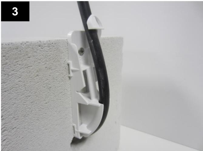
Führen Sie das Kabel unter dem 'Haken' hindurch. Zwischen dem Haken und der Biegeführung kann eine SNR-Verbindung angebracht werden. Verschließen Sie das Loch mit dem mitgelieferten Silikon, auf die 10 Ensembles zu verteilen.
