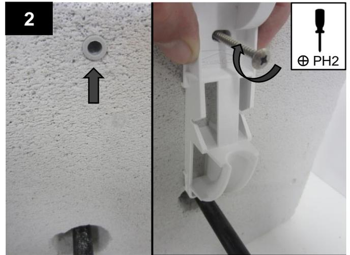
Befestigen Sie den Sockel mit der mitgelieferten Schraube und dem Dübel.
