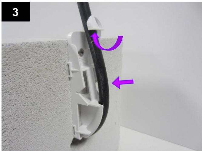
Führen Sie das Kabel unter dem 'Haken' hindurch. Zwischen dem Haken und der Biegeföhrung kann eine Schelle angebracht werden.
