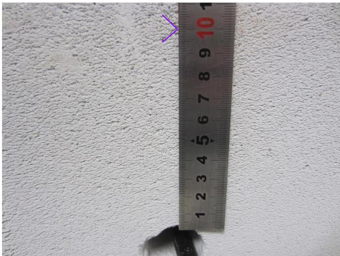
Percer le trou de fixation, Ø6mm, à 10 cm du bord du trou traversant dans le sens de courbure souhaité du câble.
